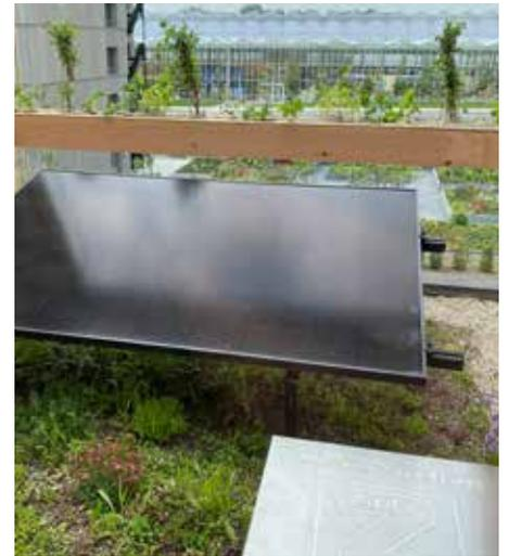
Les panneaux solaires et tapis de sédums sont une bonne combinaison. Les plantations réduisent la température et améliorent le fonctionnement des panneaux solaires.
