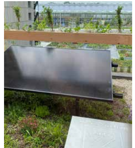
Sonnenkollektoren und Sedum-Matten sind eine gute Kombination. Die Vegetation senkt die Temperatur, sodass die Sonnenkollektoren besser funktionieren.
